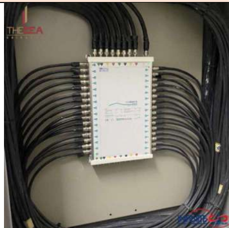
ระบบกระจายสัญญาณโทรศัพท์สนัดิจิตอล
