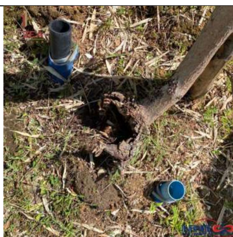
ท่อระบายก๊าซมีเทน และละอองลอย
